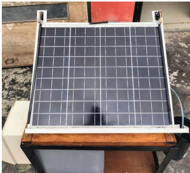
Gambar 4. 10 Kondisi Solar Cell Selama 3 Hari Menggunakan Pembersih (Sumber : Hasil Karya Penulis)
